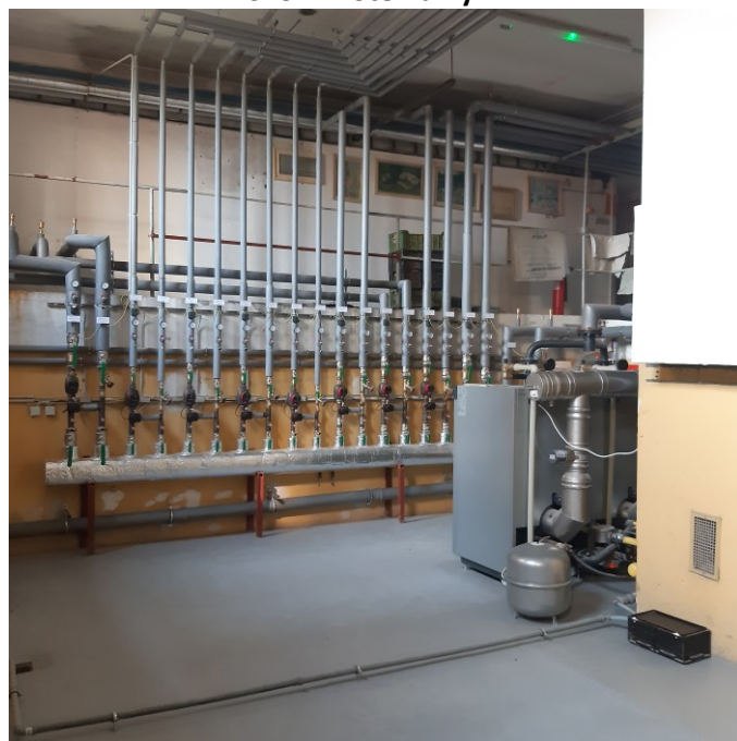
Školní kotelna nyní:
