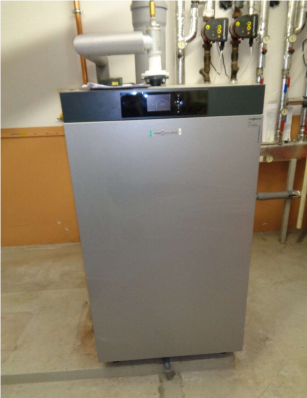
Obrázek č. 4.5.1: Plynový kondenzační kotel Viessmann, rozdělovač - sběrač ETL-EKOTHERM
