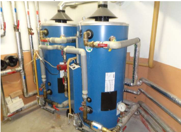
Obrázek č. 4.5.2: Plynové zásobníkové ohřivače Quantum
