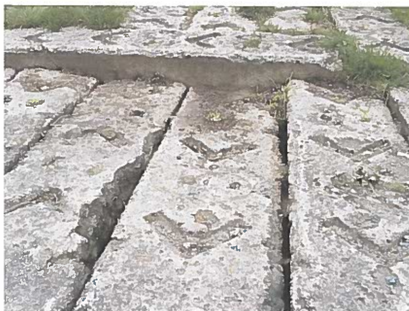
obr. 2 DETAILNÍ POHLED NA MOSTOVKU
