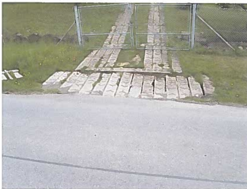
obr. 1 POHLED NA POJEZDOVÝ MŮSTEK
