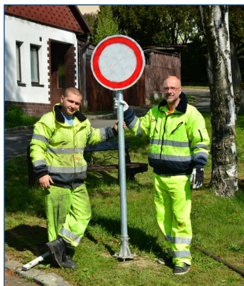
Instalace svislých dopravních značek byla realizována po celé vsi
