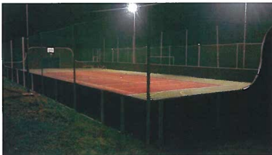
Obr. Víceúčelové sportoviště v Kostelci u Holešova
